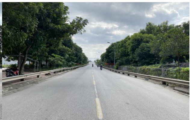
Hình 19: Đường Cầu vượt Lai Cách
