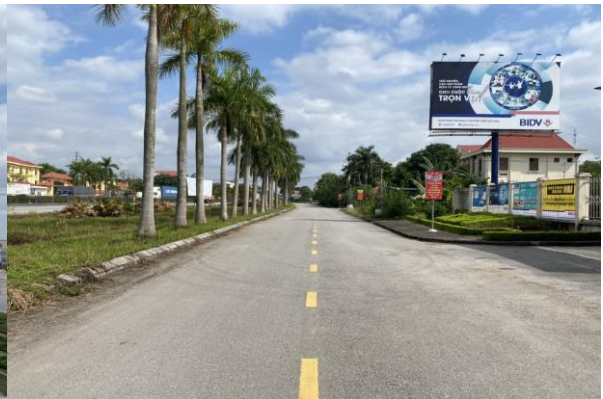
Hình 15: Đường gom QL5
